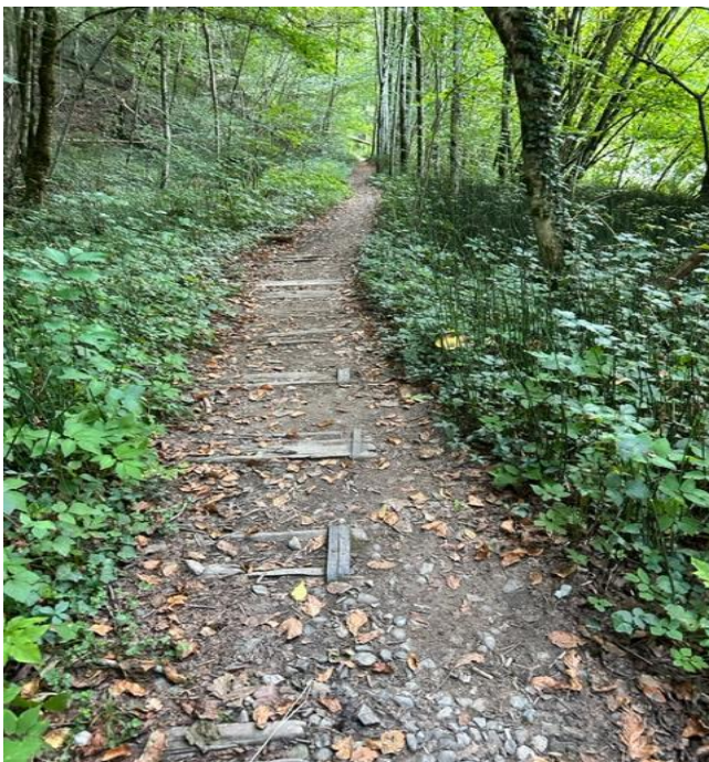
Abb. 2: Die Spuren I: Holzschwellen – Historische Eisenbahnkonstruktionen inkl. der Giftstoffe, die haltbar machen (Foto: Elisabeth Schelling)
