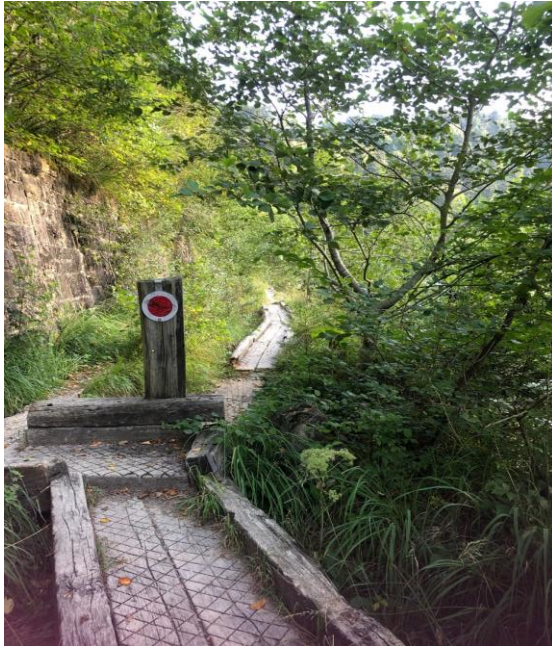
Abb. 3: Die Spuren II: Signaltechnik aus einer vorangegangenen Zeit; Bahnschwellen werden zu begehbaren Brücken, wo der Weg nicht mehr sicher genug war (Foto: Elisabeth Schelling)
